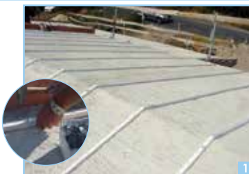
1ª Fase - Fixação do afastador perpendicular ao cume do telhado
