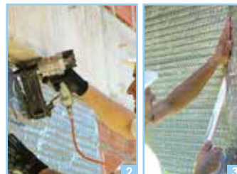
2ª Fase - Aplicação de Boltherm ao afastador
