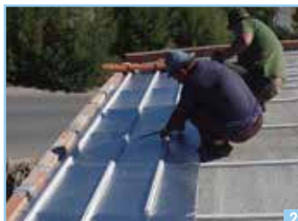
2ª Fase - Colocação de Boltherm no sentido longitudinal
