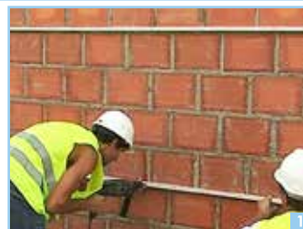
1ª Fase - Fixação do afastador ao tijolo
