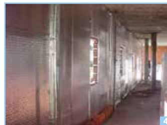
4ª Fase - Acabamento com Dupla Parede ou Placa de Gesso Carbonado
